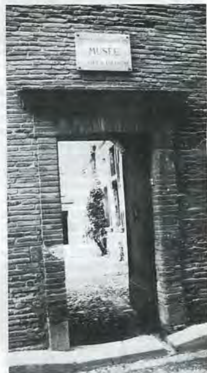
Hôtel Dumay. Entrée rue Dumay.
